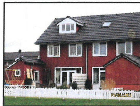
DAKKAPEL REEDS IN DE WIJK GEPLAATST (STANDAARD)
